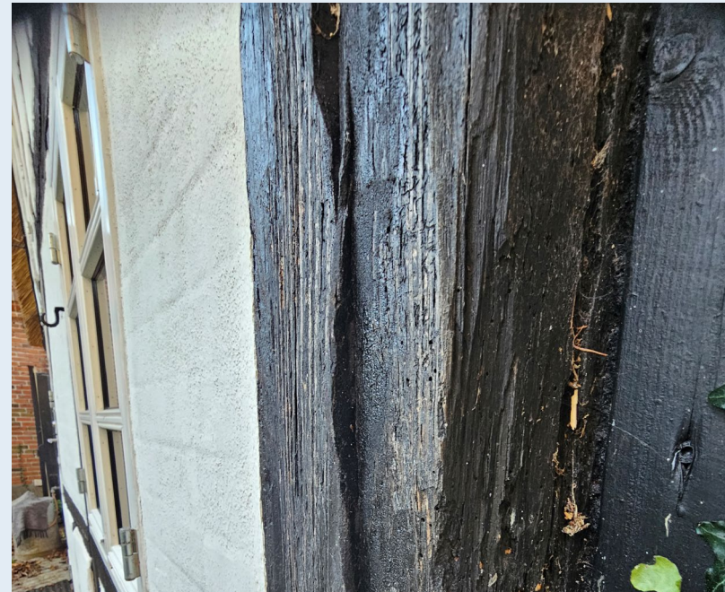
Repareret med sort tagfugemasse
