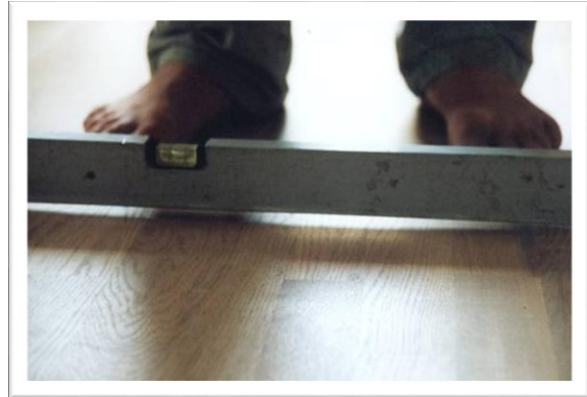
EX 7.2. Trægulv udført med varmefordelingsplader på bærebædder, som er for slappe til, at stivhedskravene kan overholdes. (Foto: Erik Brandt)
