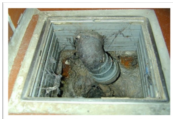
EX 6.3 Forhøjelse af afløb ved udstøbning med cementmørtel eller montering af løse rammer, som ikke passer til afløbet – i modstrid med afløbsnormen. (Foto: Erik Brandt)
