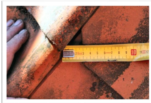
EX 1.2. Vingetegl oplagt med for ringe overlæg. De store åbninger betyder stor belastning på undertaget, som derfor kan få forkortet levetid. (Foto: Erik Brandt)
