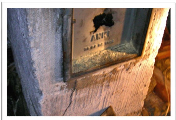
EX 1.25. Defekte renselemme giver risiko for brand og personskade. Bemærk at skorstenen tv. også har en revne. (Fotos: Aktuel Bygge Rådgivning)
