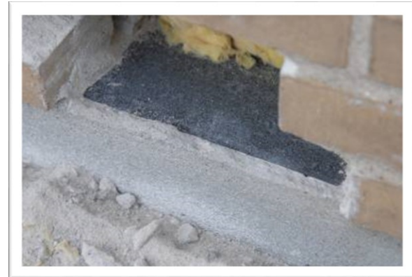
EX 4.3 Opfugtning af murværk, fordi murpappen ikke er ført frem til forkant af sokkel. (Foto: Erik Brandt)
