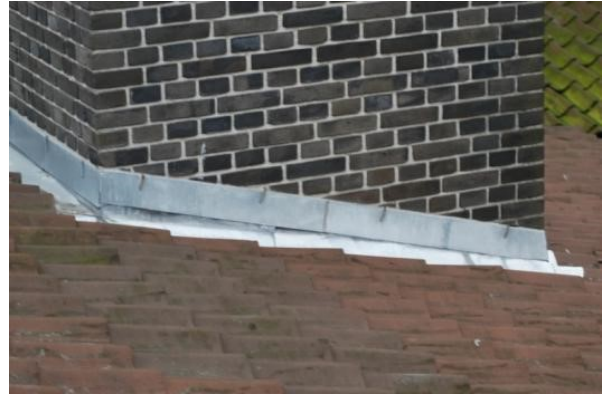
Figur 1.10. Inddækning omkring skorsten med zink-løskant indrillet i murværket (Foto: Erik Brandt).
