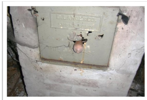
EX 1.25. Defekte renselemme giver risiko for brand og personskade. Bemærk at skorstenen tv. også har en revne. (Fotos: Aktuel Bygge Rådgivning)
