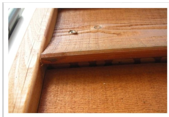
EX 2.8. Lærketræsbeklædning fastgjort så yderligt, at brædder på klink deformeres. (Foto: Niels Christoffersen)
