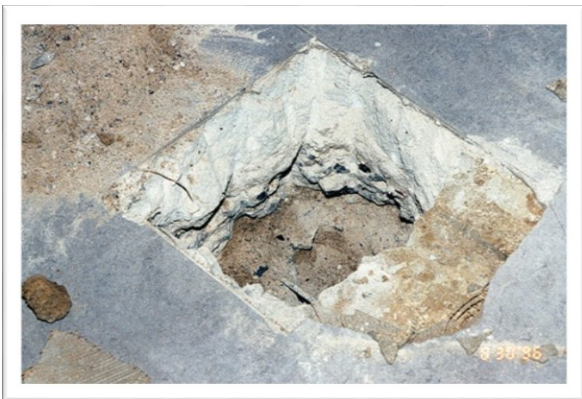
EX 5.3. Opbygning af kældergulv med beton udstøbt direkte på jord. Ved udførelse af fugtfølsomt gulvbelægning på et sådant kældergulv, SKAL der anvendes en effektiv fugtspærre, som af hensyn til risikoen for skimmelvækst bør hindre iltadgang, fx plast, asfaltpap eller epoxy. (Foto: Erik Brandt)
