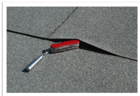
EX 1.14. Utæt svejsning af overlægget i tagpaptag. (Foto: Erik Brandt). Antal afløb fra flade tage, bør være min. 1 for hver påbegyndt 100 m 2 .
