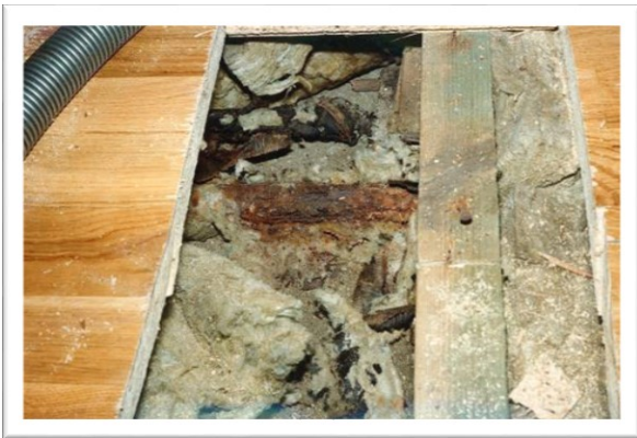
EX 5.13. I ældre gulve uden kapillarbrydende lag kan uisolerede varmerør få fugt fra underlaget til at fordampe, så trægulvet ovenpå skades. Viser sig typisk som mørke striber på gulvet eller opkvældning af spånpladegulve. (Foto: Erik Brandt)
