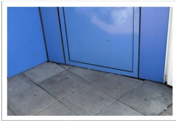
EX 4.6 Når der ikke er niveauforskel mellem dør og terrasse, er tætning under dør meget vanskelig. (Foto: Erik Brandt)
