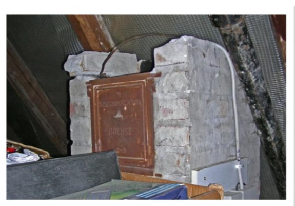
EX 1.27. Skorstenspipe er fjernet, men resten af skorstenen står tilbage. Der kan trænge fugt op gennem skorstenen, fx fra fugtig kælder. (Foto: Aktuel Bygge Rådgivning)
