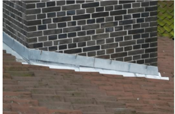
Figur 1.10. Inddækning omkring skorsten med zink-løskant indrillet i murværket (Foto: Erik Brandt).
