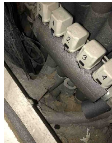
Installationsskab, hvor der ikke er udført tætning i gulvet.
