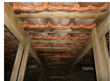
Lægter viser tegn på, at taget ikke er tæt og skummet berører træet.
