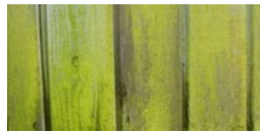
Alger på udvendig træbeklædning med tydelig opfugtning nederst.
