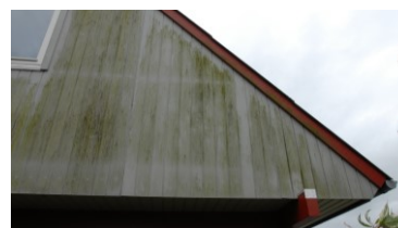
Alger på gavl (mod nord).
