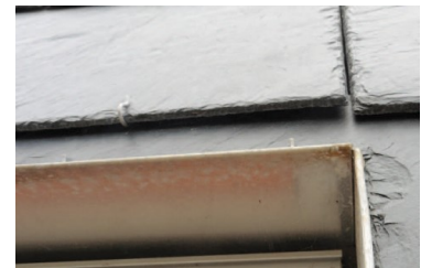
Saltholdigt vand fra MgO-plader har medført korrosion på inddækning omkring vindue.
