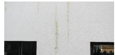
Misfarvning af puds, som er udført på MgO-plade.
