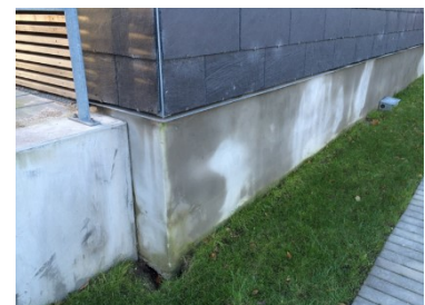
Sokkel, der er opfugtet af vand, der siver ud af facaden fra ydersiden af den vindtætte MgO-plade.
