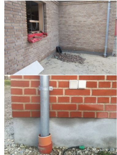
Skalmure, der som følge af "svedende MgO-plader" bliver opfugtet indefra.
