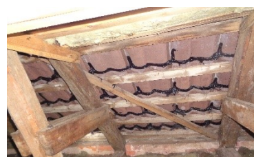
Understrygning af bitumen er intakt.
