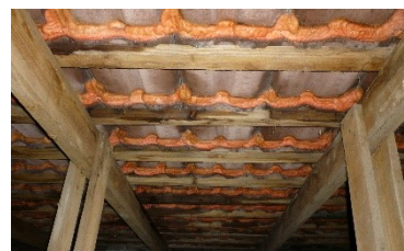
Understrygning af polyuretan, hvor der er store fugtproblemer.
