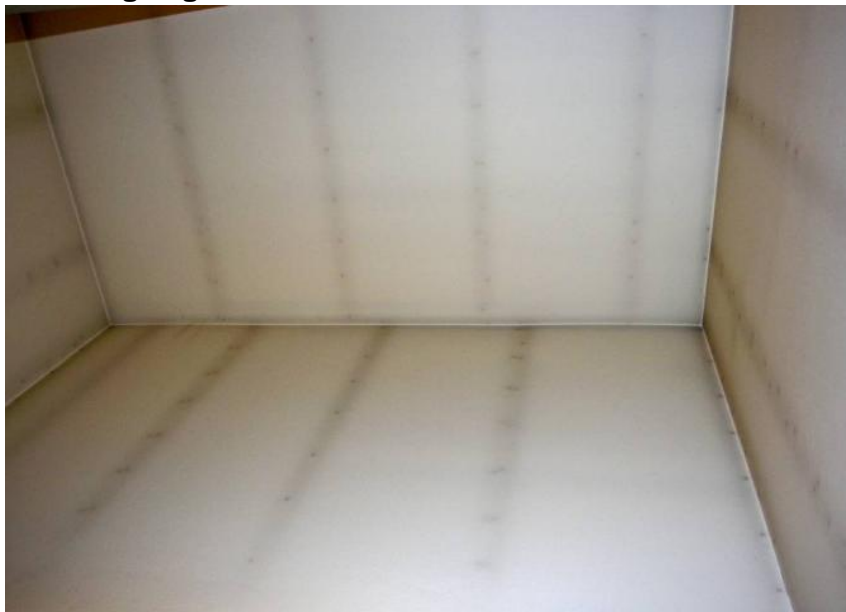
EX 9.7. Kuldebroer på loft pga. luft, der kommer ind under dampspærren. (Foto: Erik Brandt)
