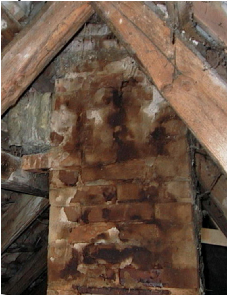
EX 1.24. Løbesod på skorsten indikerer, at der kan være problemer med fugtindtrængning og/eller dårlig forbrænding. Her vurderes ift. om skorstenen er i brug eller ej. (Foto: Peter Olsson)
