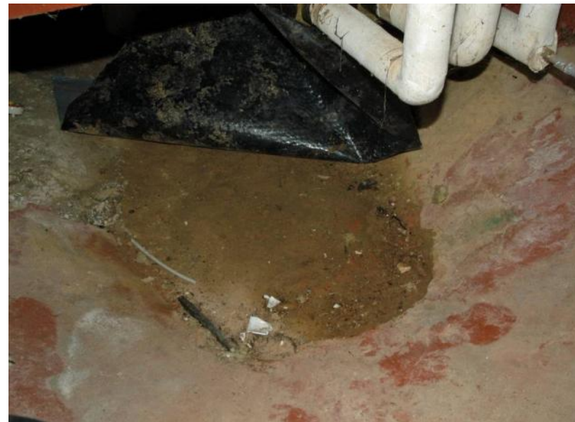
EX 5.10. Krybekælder med fugtig jord i bunden. Der kan afgives store fugtmængder fra jorden som kan medvirke til at gøre krybekælderen fugtig. (Foto: Erik Brandt)
