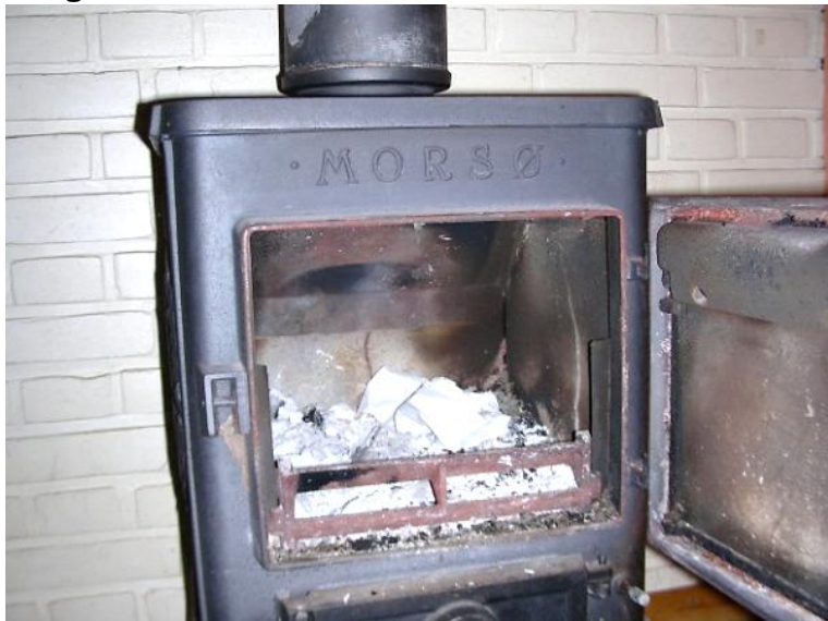
EX 1.26. Revnede og smådefekte udmuringssten. Hvis stenene falder ned vil ovnsiderne blive rødgldende. (Foto: Aktuel ByggeRådgivning)
