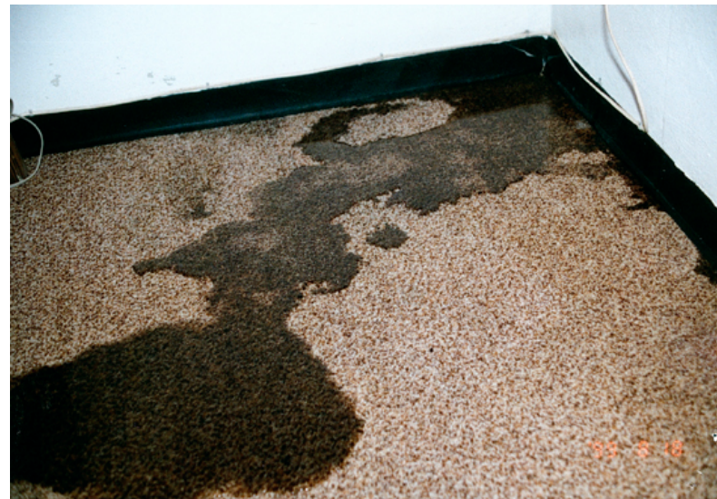
EX 5.2. Vandindtrængning i ældre kælder under regnvej. Kældre må altid forventes at være tætte mod vand fra almindelig nedbør – ellers skal ejeren oplyse det. (Foto: Erik Brandt)
