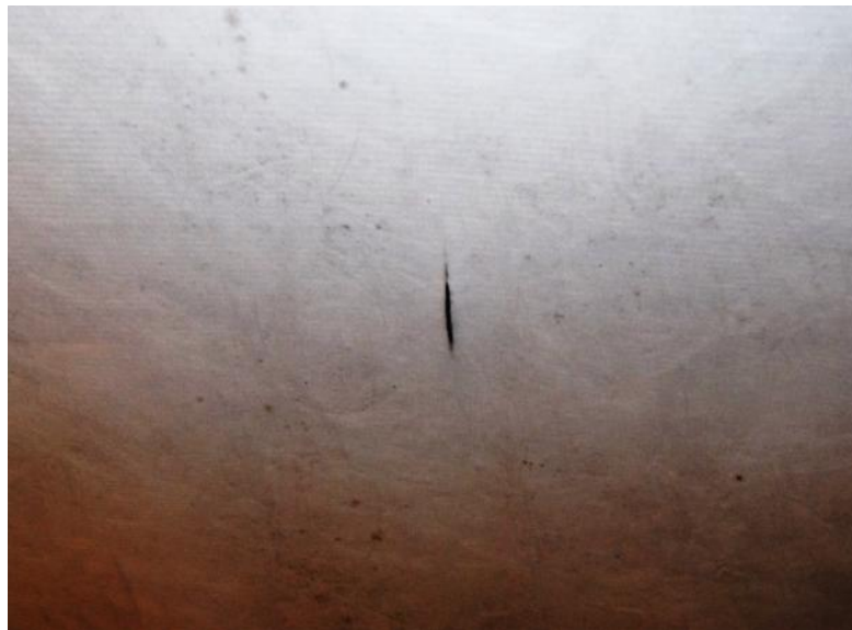
EX 1.8. Hul efter binder i undertag – tætheden er ødelagt ved binderen pga. blafring. (Foto: Erik Brandt)
