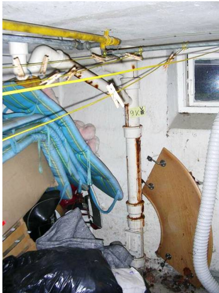
EX 11.11. Gennemtærede støbejernsfaldstammer samlet med blystøbning, hvilket tidligere både var eneste mulighed og lovligt. (Foto: Aktuel ByggeRådgivning)
