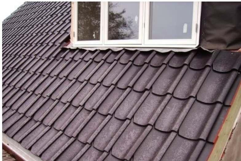
EX 1.10. Inddækning under kvist er ikke udført, så vandaflledning sikres. (Foto: Aktuel Bygge Rådgivning)
