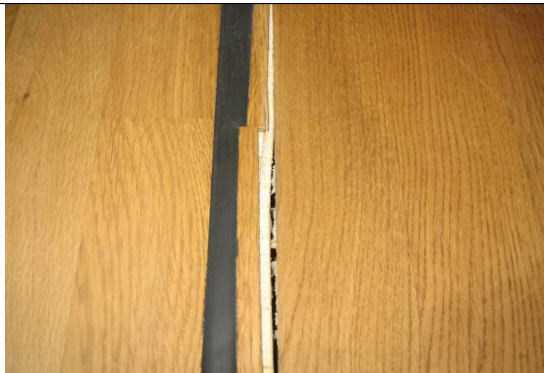
EX 7.3. Fugning af trægulv med stærk fugemassefuge, der fungerer som lim. (Foto Erik Brandt)
