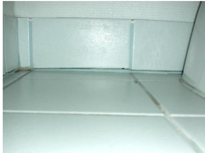
EX 6.11. Sætninger i gulvpladen, fuger slipper. (Foto: Aktuel Bygge Rådgivning)
