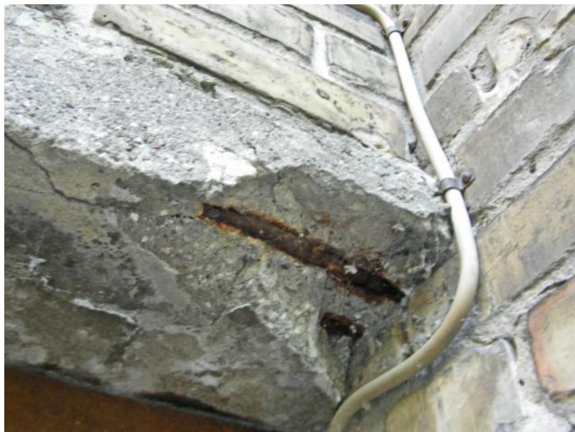
EX 2.9. Forbindelse mellem hus og altanplade, udliggerjernet ligger blottet og er ikke længere beskyttet af beton. (Foto: Aktuel ByggeRådgivning)
