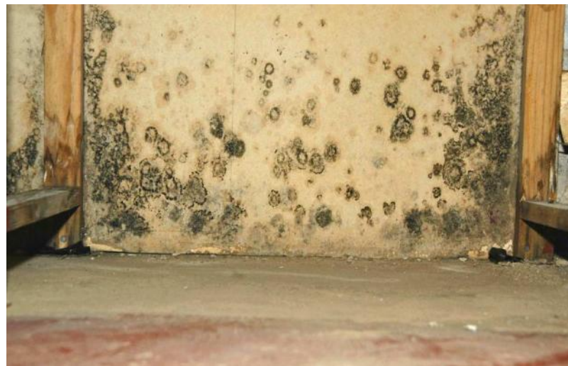
EX 5.4. Skimmelvækst på tapetseret kælderydervæg pga. opfugtning forårsaget af defekt dræn. (Foto: Erik Brandt)
