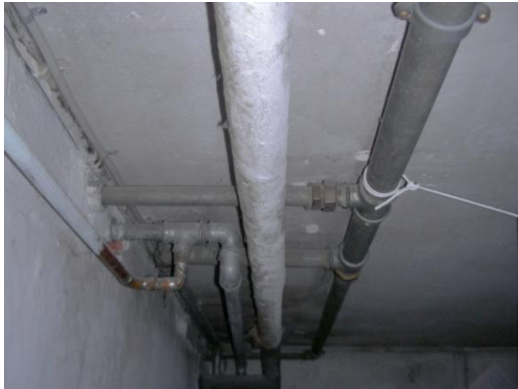
EX 11.8. Radiatorforskrutninger anvendt til samling af galvaniserede brugsvandsrør. Overhængende risiko for tæring. (Foto: Aktuel ByggeRådgivning)
