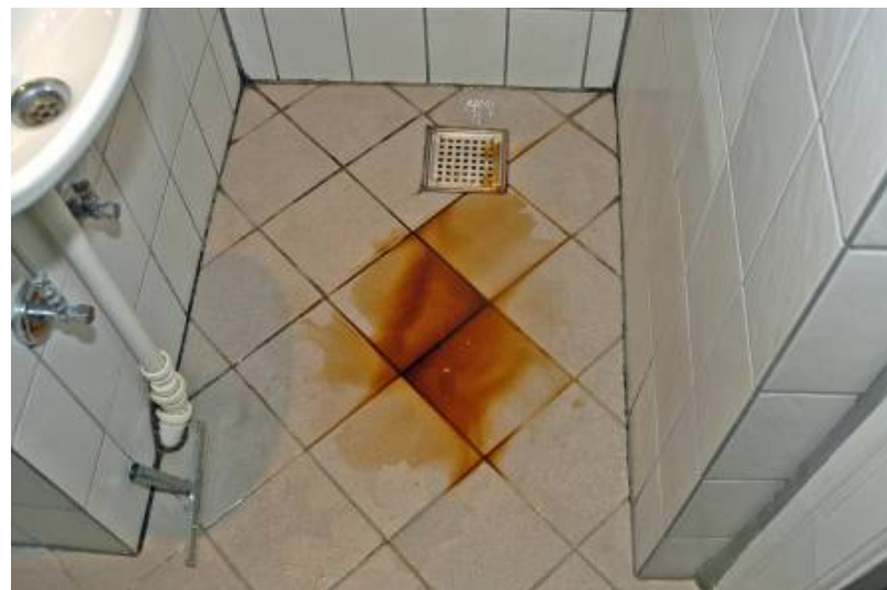
EX 6.2. Lunke på badeværelsesgulv – gjort fotogen med lidt vand med kulør i. (Foto: Erik Brandt)
