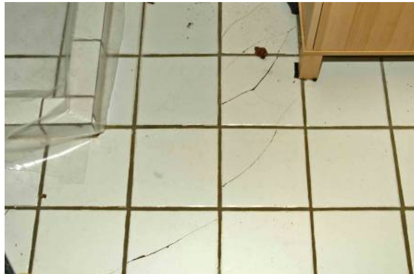
EX 6.9. Gennemgående fuger kan være tegn på skader i underlaget – her råd i en træplade. (Foto: Erik Brandt)
