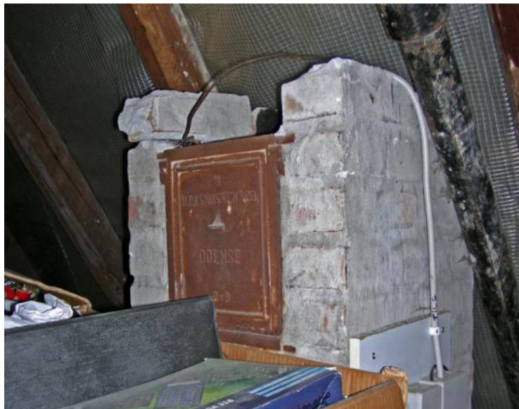
EX 1.27. Skorstenspipe fjernet, men resten af skorstenen står tilbage. Der kan trænge fugt op gennem skorstenen, fx fra fugtig kælder. (Foto: Aktuel ByggeRådgivning)
