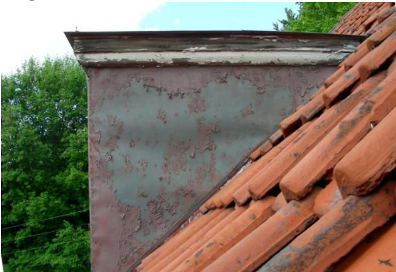
EX 1.17. Inddækninger og tag på kviste skal vedligeholdes. (Foto: Aktuel Bygge Rådgivning)
