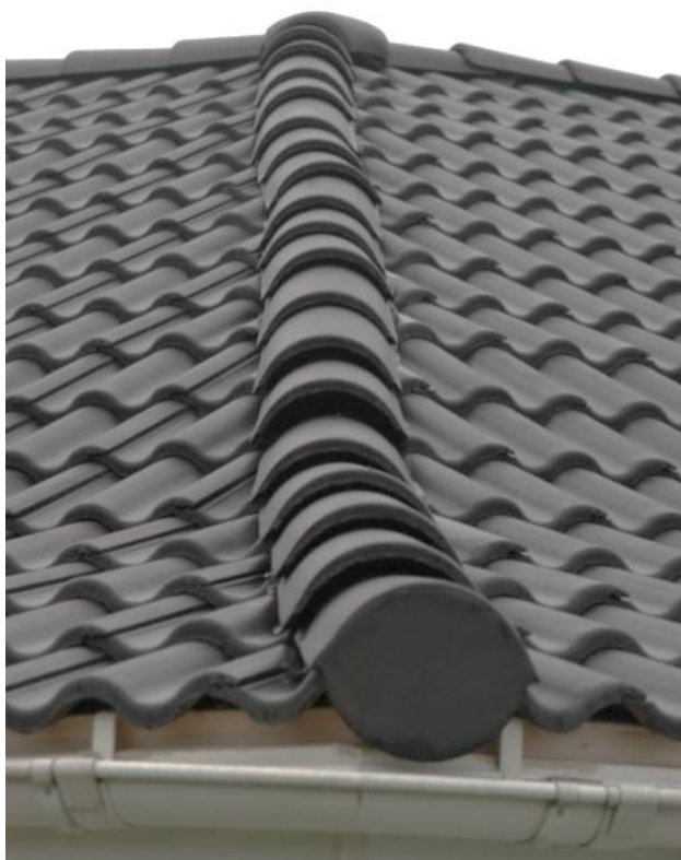
EX 1.3. Grat er skæv på grund af sjusket arbejde. Der kan i tilknytning hertil være problemer med afslutning af undertag mod gratplanke. (Foto: Erik Brandt)
