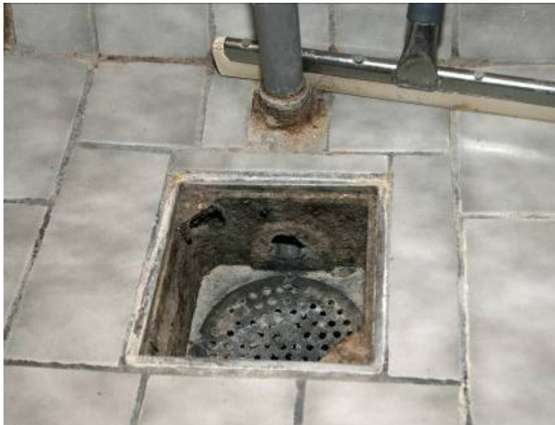
EX 6.3 Forhøjelse af afløb ved udstøbning med mørtel eller montering af løse rammer som ikke passer til afløbet – i modstrid med Afløbsnormen. (Foto: Erik Brandt)
