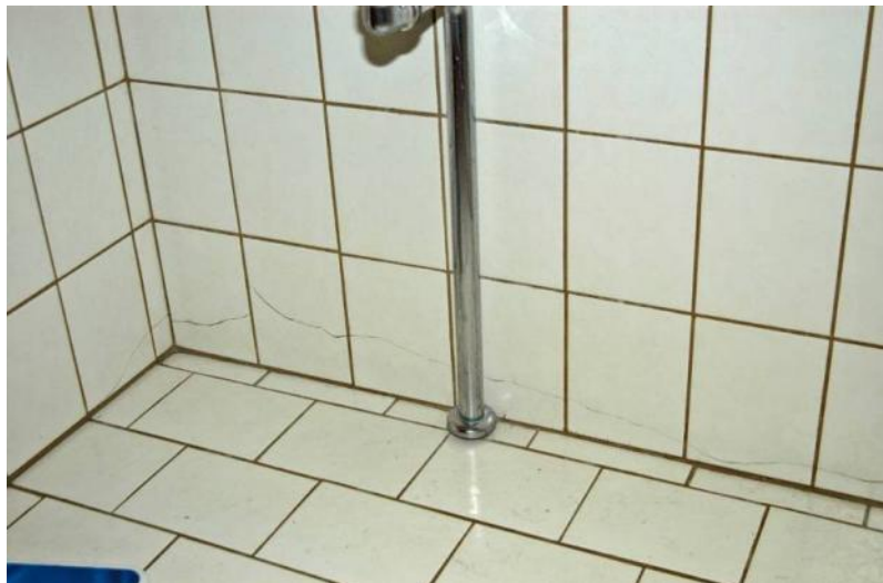
EX 8.1. Revne i indervæg pga. sætning i underlaget (bærende dæk). (Foto: Erik Brandt)
