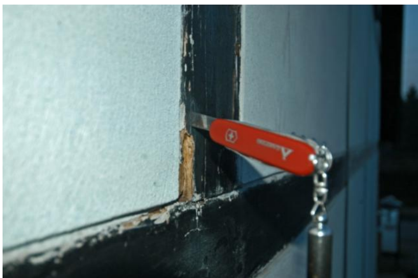
EX 2.7. Nedbrudt bindingsværk er meget almindeligt, hvis der ikke sker løbende vedligehold. (Foto: Erik Brandt)
