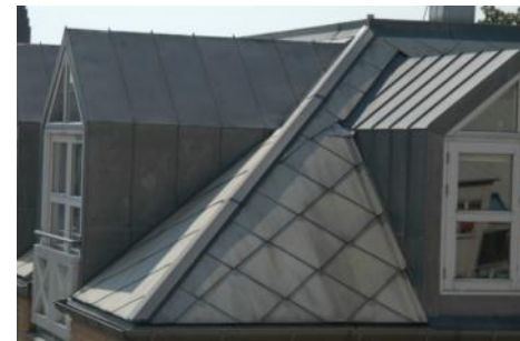
Figur 1.5. Skifertage kan oplægges på forskellig måde, fx diagonalt, som vist her. (Foto: Erik Brandt)
