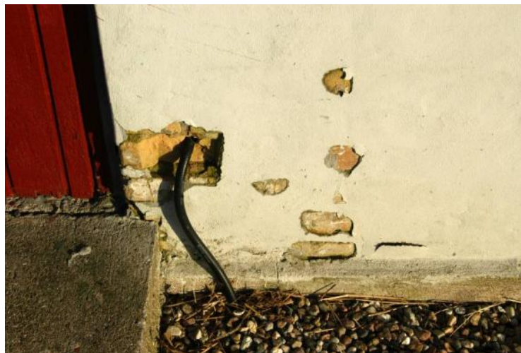
EX 4.2. Opfugtning af murværk i ældre bygning pga. manglende fugtspærre. (Foto: Erik Brandt)
