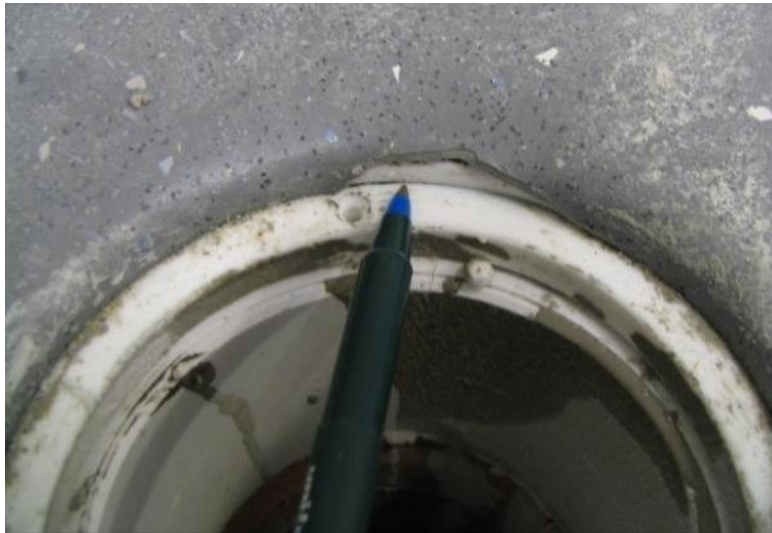
EX 11.5. Sjusket udført samling mellem pvc og (korrekt) gulvafløb – ingen vandtæthed – gennemtrængning kan ses fra undersiden af etageadskillelsen. (Foto: Erik Brandt)
