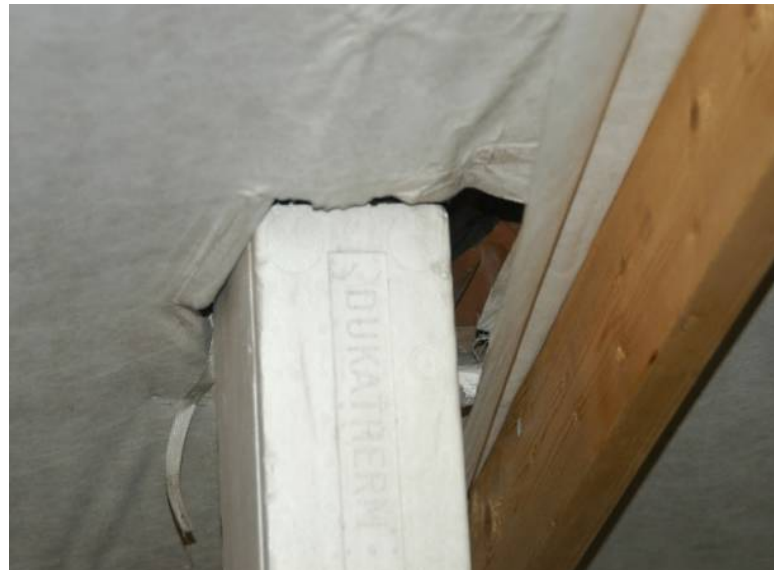
EX 1.6. Forkert udført gennemføring. Underlag mangler og samlingen er ikke tæt. (Foto: Erik Brandt)
