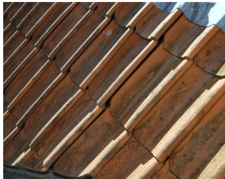
EX 1.4. Vingetegl oplagt med for ringe overlap/åbne sidesamlinger. De store åbninger betyder stor belastning på undertaget, som derfor kan få forkortet levetid. (Foto: Erik Brandt)
