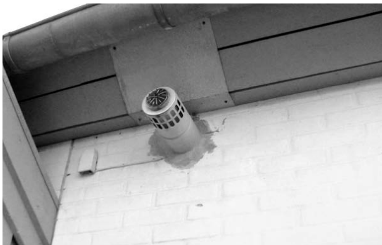
EX 11.12. Balanceret aftræk fra gasfyr. Der er risiko for skader som følge af kondens pga. afkastluft, som kan trænge ind i tagkonstruktionen via udhænget. (Foto: Aktuel ByggeRådgivning)
