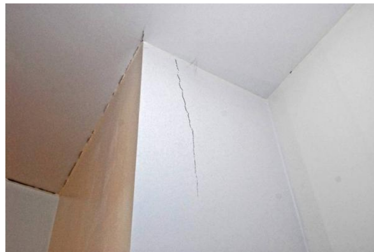
EX 9.6. Revne mellem etageadskillelse og væg pga. fugtbevægelser af tagelementer med gennemgående træribber. Taget krummer opad om vinteren, når indersiden af ribberne tørrer ud. (Foto: Erik Brandt)
