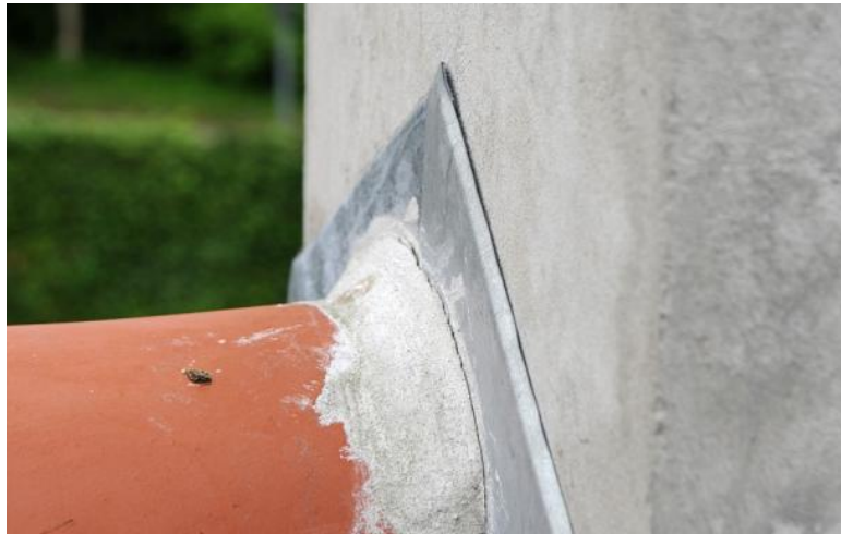
EX 1.23. Inddækning af skorsten uden på pudsen – uden indrilning – det medførte vandindtrængning. (Foto: Erik Brandt)
