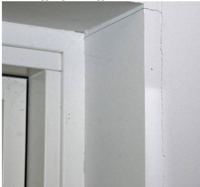
EX 8.3. Revne i samling indervæg/lysningspanel pga. svind i lysningspanel og bagmur. (Foto: Erik Brandt)
