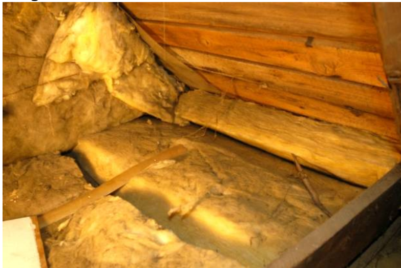
EX 1.9. Dårligt udlagt isolering, som tillige har blokeret ventilationen. (Foto: Erik Brandt)
