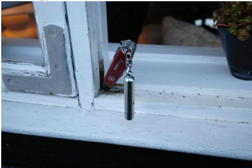
EX 3.5. Nedbrudt træ i samling i gammelt vindue uden fald på bundfals. (Foto: Erik Brandt)
