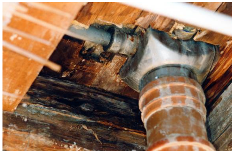
EX 11.2. Afløb til indstøbning monteret i træ. (Foto: Erik Brandt)
