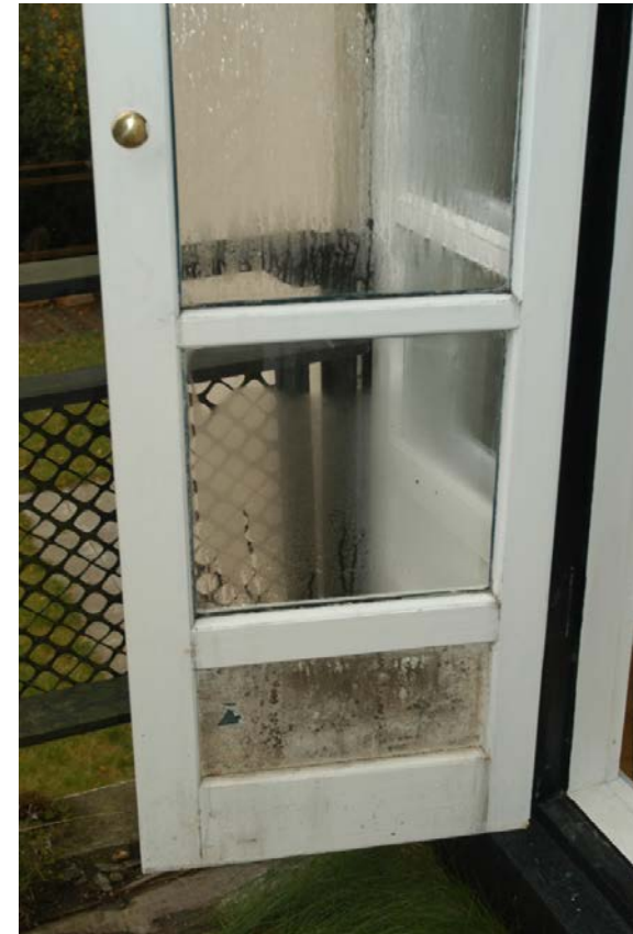
EX 3.4. Kondens på glas i yderste ramme ved dør med forsatsramme. (Foto: Erik Brandt)
