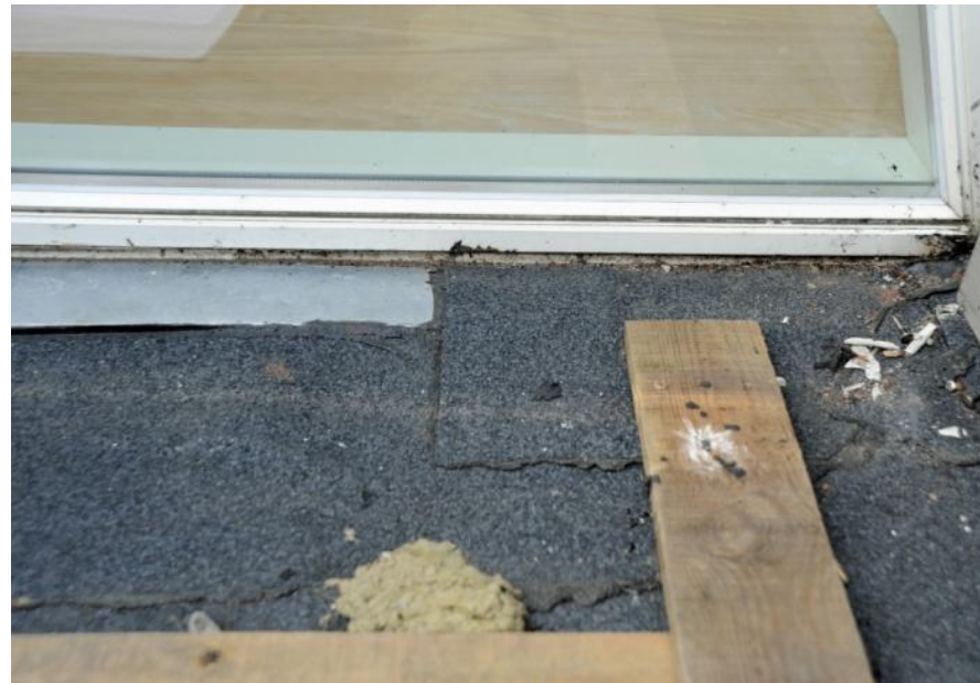
EX 2.12. Tagterrasse med lav inddækningshøjde mod vindue med stor risiko for fugtskader til følge. (Foto: Erik Brandt)
