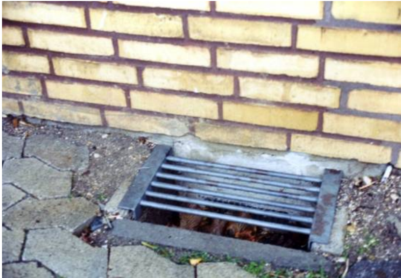
EX 5.7. Ventilationsrist anbragt under terræn. Placeringen hindrer fri gennemstrømning af ventilationsluft, og antallet af ventilationsåbninger skal derfor forøges med 50 %. Hvis der er fald mod en sådan rist, vil vand kunne trænge ind i krybekælderen, og hverken sne eller regn på facaden kan holdes væk fra krybekælderen. (Foto: Erik Brandt)
