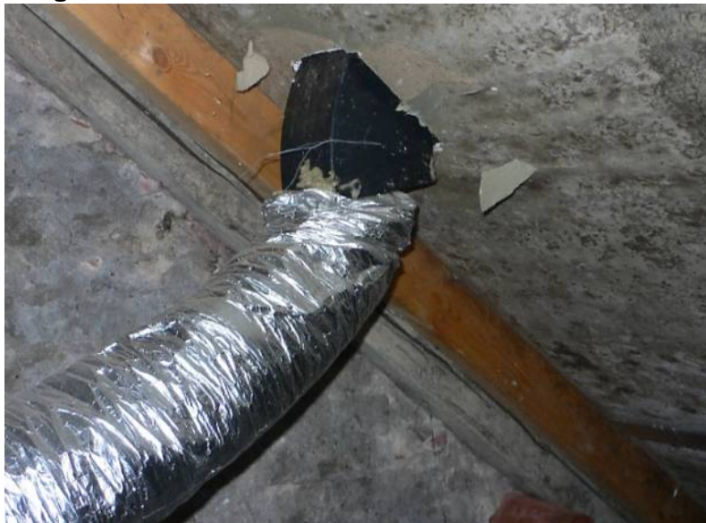
EX 1.7. Ukorrekt udført gennemføring i undertag af gipsplade samt skimmelvækst på pladens overflade. (Foto: Erik Brandt)
