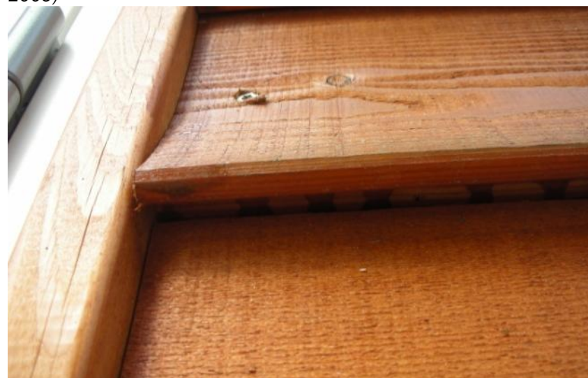
EX 2.8. Lærketræsbeklædning fastgjort så yderligt, at brædder på klink deformeres. (Foto: Niels Christoffersen)
