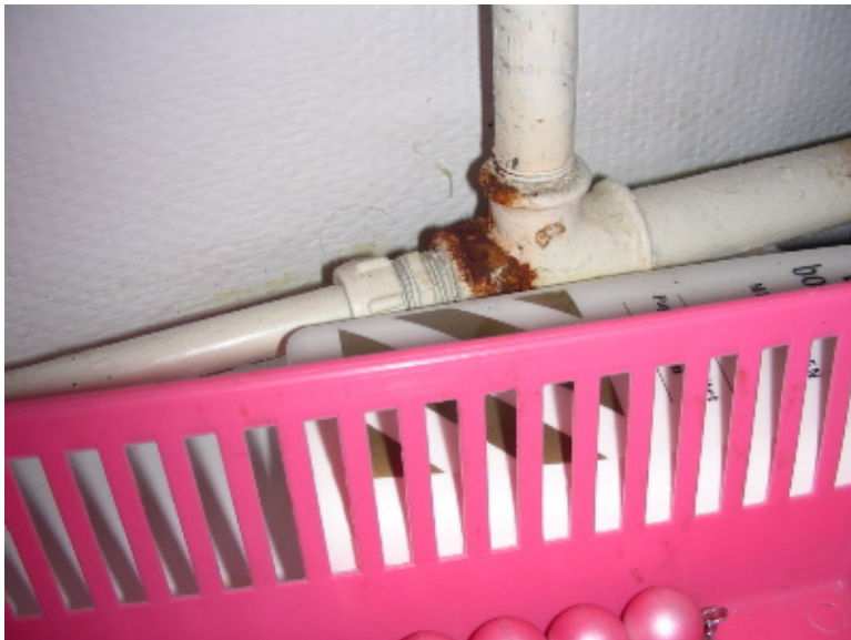
EX 11.7. Korrosion ved samling mellem stålør og kobberør (uden anvendelse af ionfælde (grisehale)). (Foto: Aktuel ByggeRådgivning)
