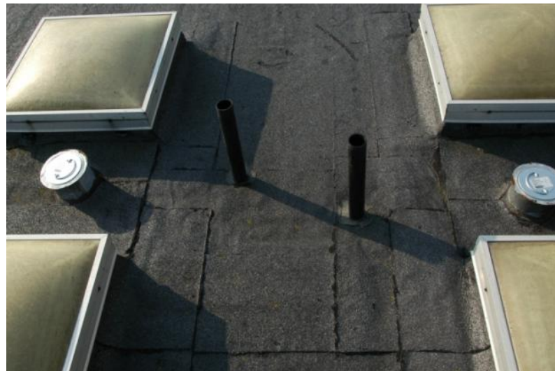
EX 1.12. Stort antal gennemføringer tæt sammen øger risikoen for utætheder/skader pga. dårlige betingelser for arbejdsudførelse. (Foto: Erik Brandt)
