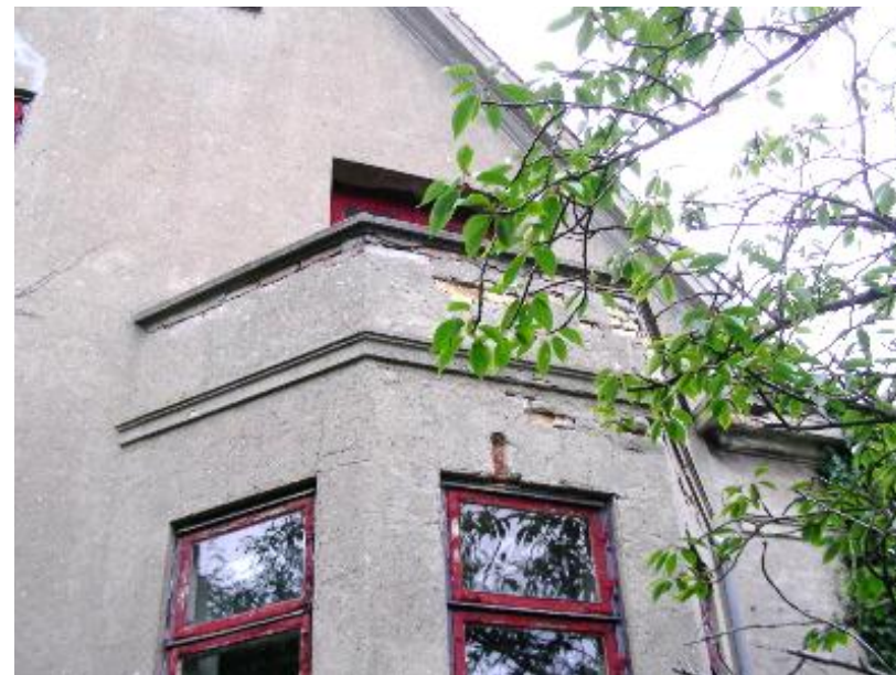
EX 2.10. Tagterrasse med frostskeer på værn. (Foto: Aktuel ByggeRådgivning)
