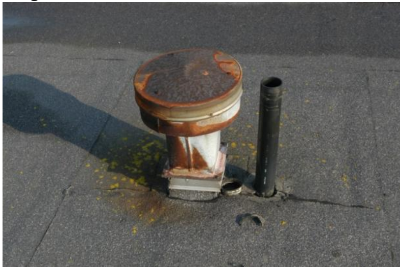
EX 1.13. Ukorrekt udførte gennemføringer – for tæt sammen til at samlinger kan udføres korrekt. (Foto: Erik Brandt)
