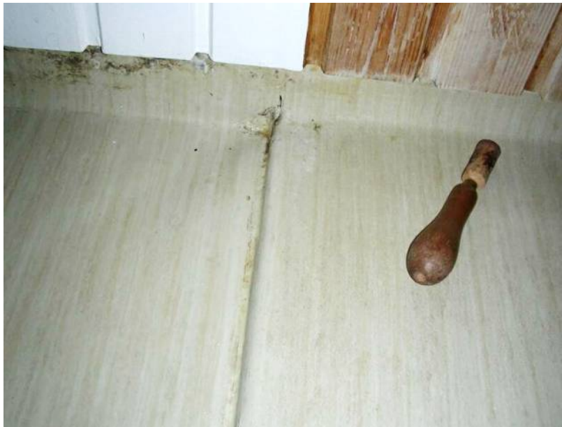
EX 6.12. Forsænket bruseniche med pvc-belægning 1. sal i et hus med træetageadskillelse. I overgangen til forsænkningen er der en lodret revne. Træbeklædningen på væggen overlapper pvc'en. Træbeklædningen har ikke været tilladt i vådzone siden 1995. (Foto: Aktuel Bygge Rådgivning)
