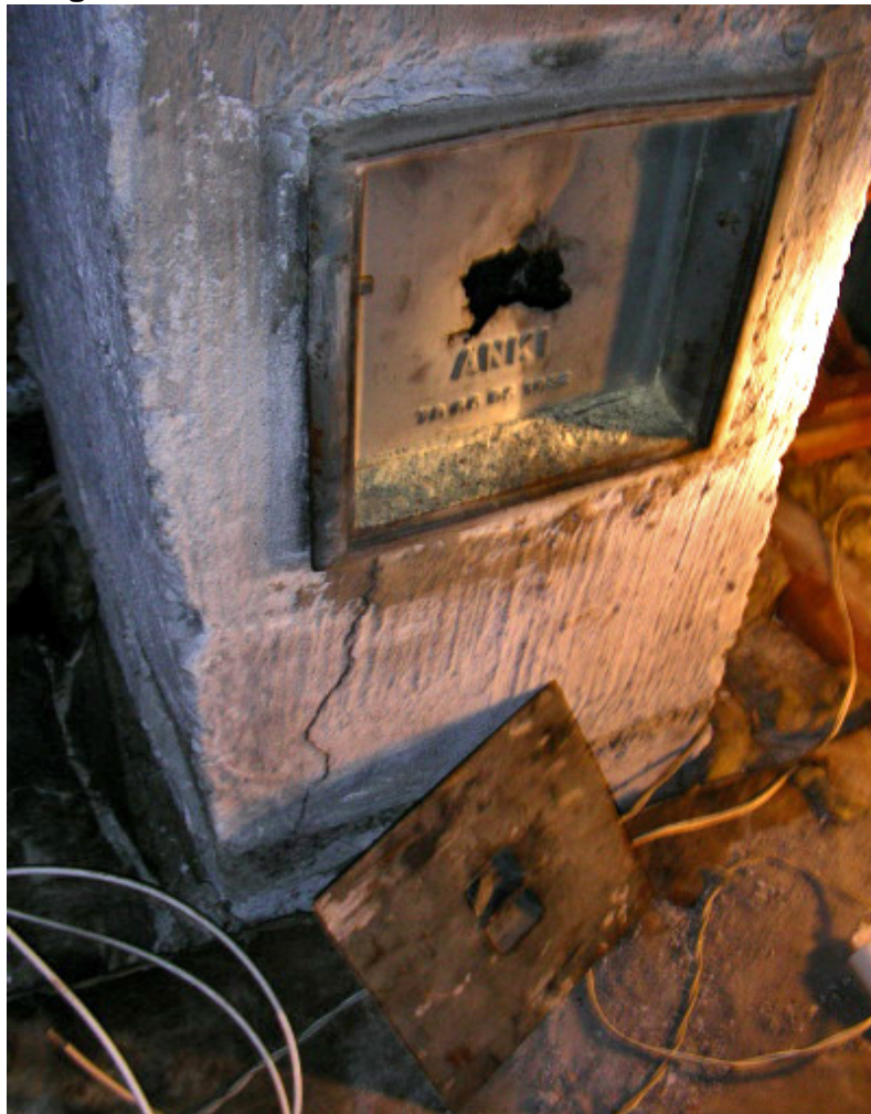
EX 1.25. Defekte renselemme giver risiko for brand og personskade. Bemærk at skorstenen tv. også har en revne. (Fotos: Aktuel Bygge Rådgivning)
