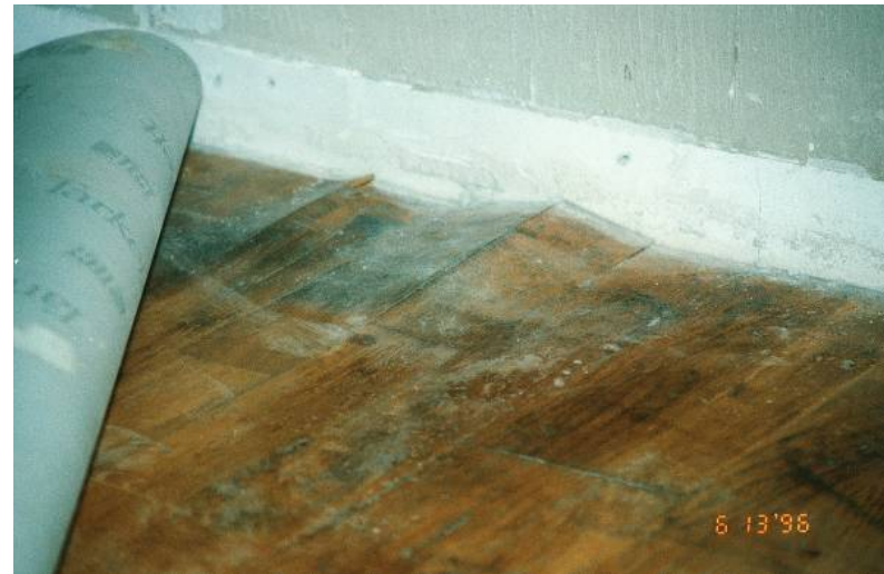
EX 5.12. Trægulv på terrændæk uden kapillarbrydende lag. Gulvet er skadet fordi der er lagt en diffusionstæt pvc-belægning på trægulvet, hvorved fugten fra underlaget ikke længere kan slippe ud gennem gulvet. (Foto: Erik Brandt).
