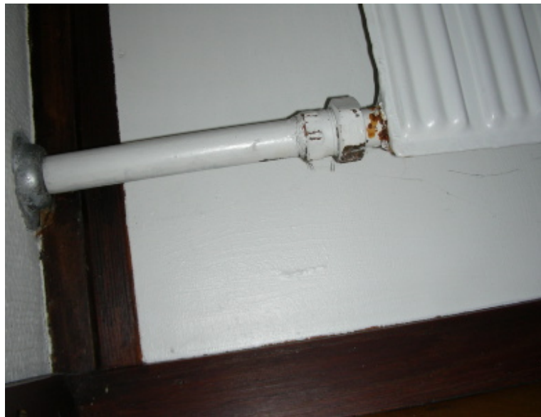
EX 11.10. Utæthed pga. korrosion i varmeanlæg, sandsynligvis som følge af tidligere åbent centralvarmeanlæg, nu ombygget til lukket anlæg. Dryp på parketgulvet! (Efter 1972). (Foto: Aktuel ByggeRådgivning)
