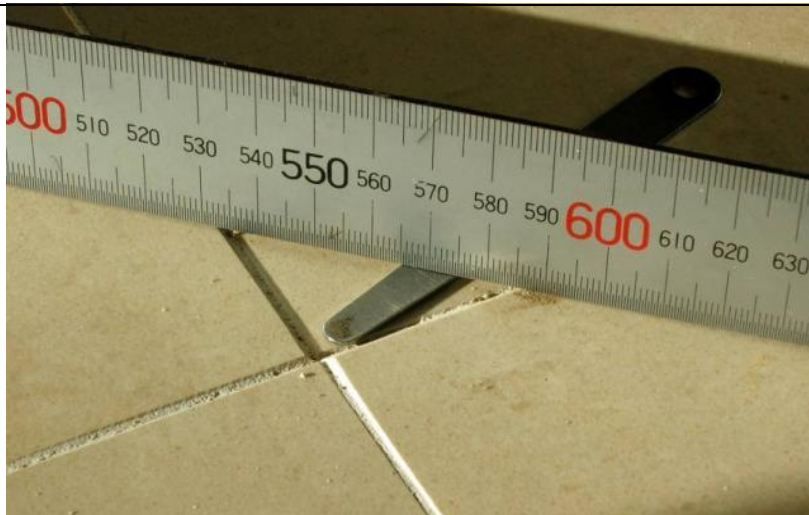
EX 7.5. Spring mellem fliser – omfanget af store spring skal være begrænset og de må ikke være over 1 mm, jf. Fliser på væg og gulv, E. Brandt, Forlaget Tegl 2006. (Foto: Erik Brandt)
