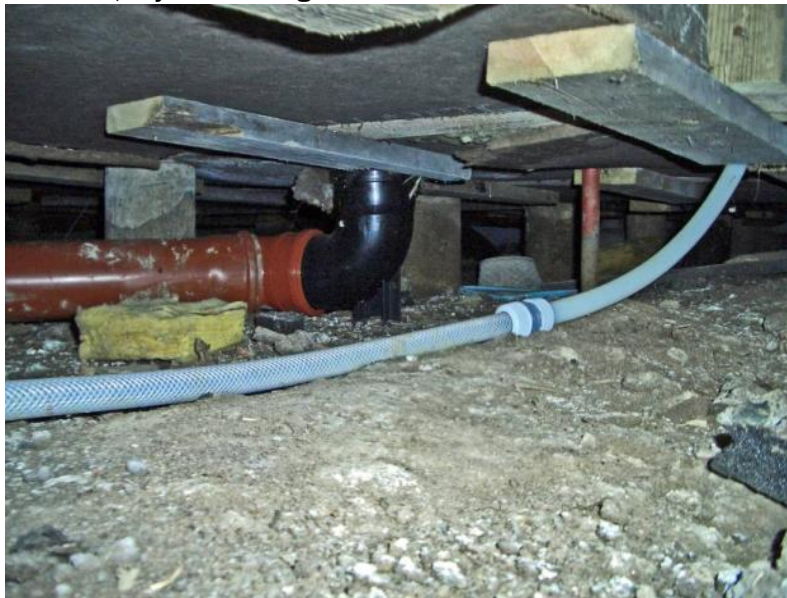
EX 5.9. Krybekælder med jord i bunden uden afdækning. Der er trukket uisolerede rør i krybekælderen med deraf følgende risiko for frostproblemer. (Foto: Erik Brandt)
