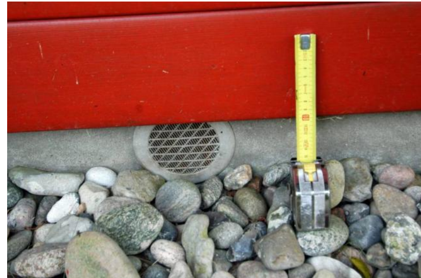
EX 5.8. Ventilationsrist anbragt med underkant ved terræn (i strid med reglen om, at underkant skal være mindst 100 mm over terræn), hvilket betyder, at smeltevand fra sne og i uheldige tilfælde regnvand kan trænge ind i kryberummet. Sokkelhøjden er kun 10 cm, hvilket er for lidt ved træbeklædning. (Foto: Erik Brandt)
