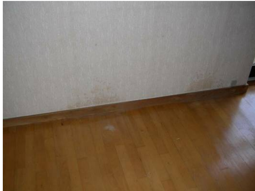
EX 6.13. Eksempel på fugtbeskadiget væg på bagsiden af væg i brusenichen. (Foto: Aktuel Bygge Rådgivning)
