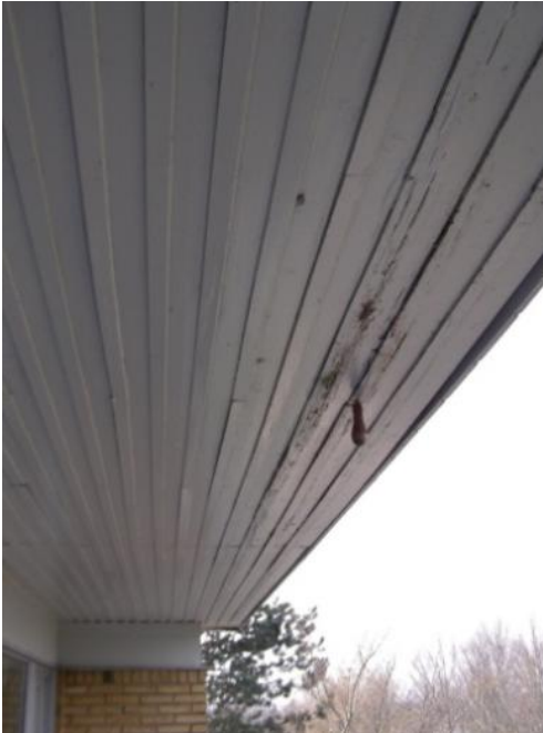
EX 1.15. Sternbrædder / underbeklædning kan være rådne bag malingen. (Foto: Aktuel Bygge Rådgivning)
