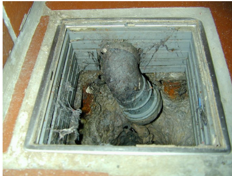
EX 6.3 Forhøjelse af afløb ved udstøbning med mørtel eller montering af løse rammer som ikke passer til afløbet – i modstrid med Afløbsnormen. (Foto: Erik Brandt)
