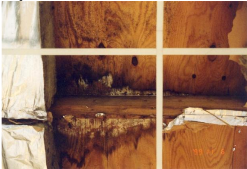
EX 1.11. Skimmelvækst på tagunderlag pga. defekt dampspærre. (Foto: Erik Brandt)
