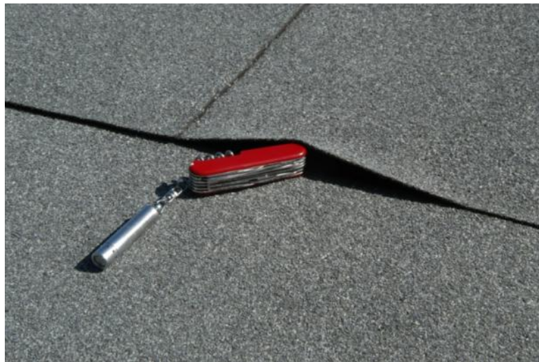
EX 1.14. Utæt svejsning af overlægget i tagpaptag. (Foto: Erik Brandt) Antal afløb fra flade tage, bør være min. 1 for hver påbegyndt 100 m 2 .
