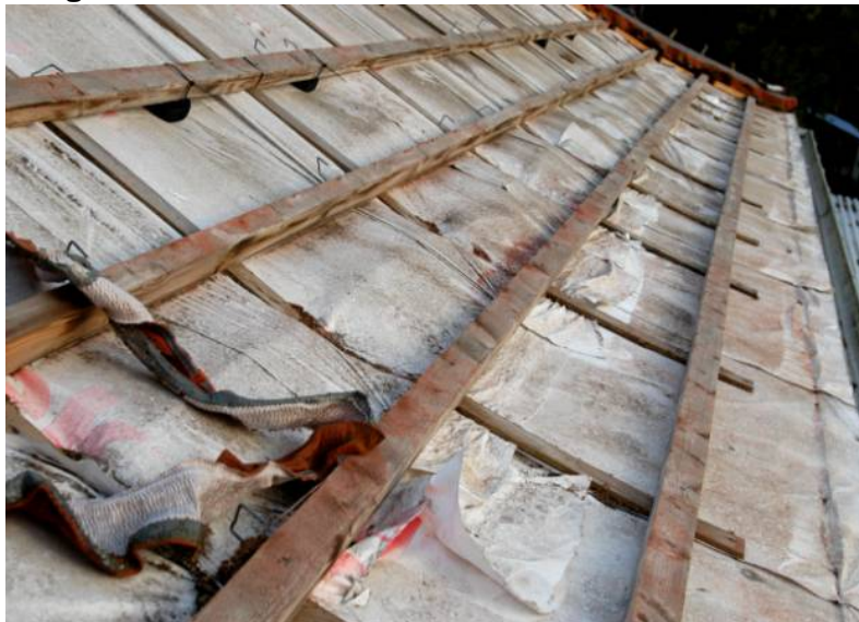
EX 1.5. Sjusket udført undertag – kan også ses fra undersiden/loftsrummet, vandtætheden er tvivlsom. (Foto: Erik Brandt)
