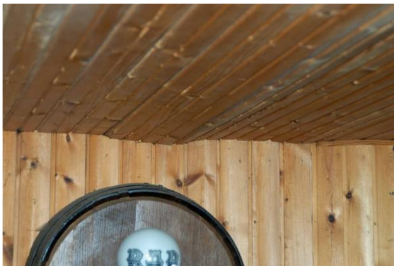
EX 9.5. Ujævn bræddebeklædning på loft pga. manglende indgreb i fer-not. (Foto: Erik Brandt)
