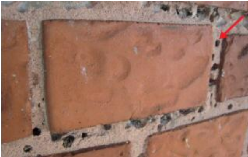
EX 2.3. Fuger angrebet af murbier, hullerne (vist ved rød pil) er 5-6 mm i diameter. (Kilde: BYG-ERFA blad (21) 10 05 19)
