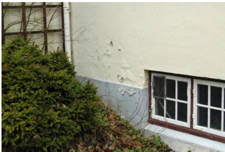
EX 4.8. Opfyldning af jord langs huset til over fugtspærre – her ved etablering af terrasse – kan medføre opsugning af fugt i murværket. (Foto: Erik Brandt)
