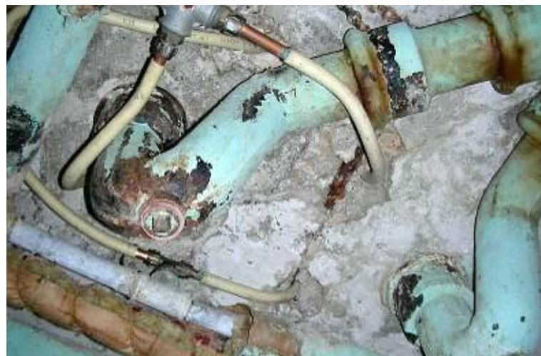
EX 11.13. Kælderdæk med tæringsskader som følge af utilstrækkelig tætning mellem afløbsskålen og gulvkonstruktionen. (Foto: Aktuel ByggeRådgivning)
