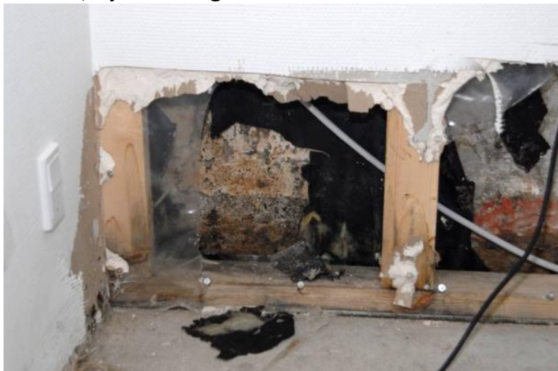
EX 5.5. Skimmelvækst på oprindelig kældervæg og på træskelet (uimprægneret). I dette tilfælde skyldes skimmelvæksten på væggen fugt udefra. (Foto: Erik Brandt)
