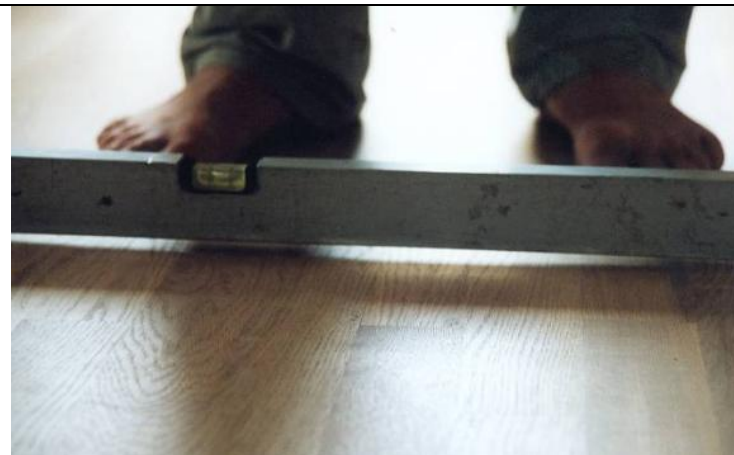
EX 7.2. Trægulv udført med varmefordelingsplader på bærebædder som er for slappe til at stivhedskravene kan overholdes. (Foto: Erik Brandt)
