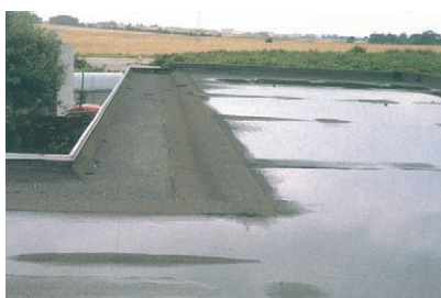
Vandsamling på fladt tag (foto: BYG-ERFA).
