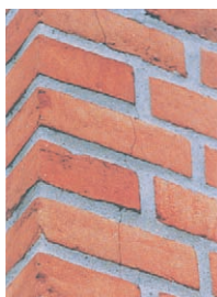
Revner i ydervæg af murværk (foto: BYG-ERFA)
