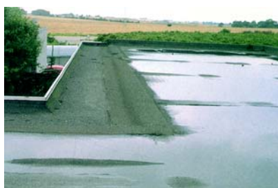
Vandsamling på fladt tag (foto: BYG-ERFA).
