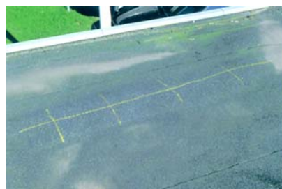
Dampbuler (foto: BYG-ERFA).
