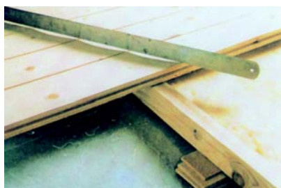
Brædegulv med "vaskebræt"-overflade (foto: BYG-ERFA)
