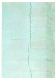
Revner i ydervæg af murværk (foto: BYG-ERFA)
