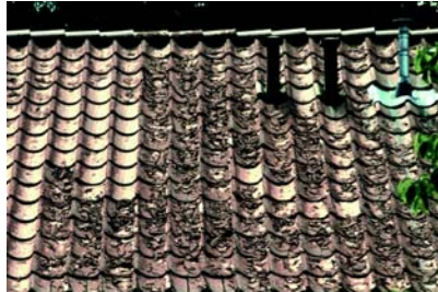
Afskalninger (foto: Byggeskadefonden)
