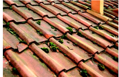
Afskalninger (foto: Byggeskadefonden)
