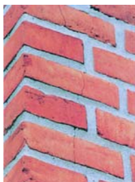
Revner i ydervæg af murværk (foto: BYG-ERFA)
