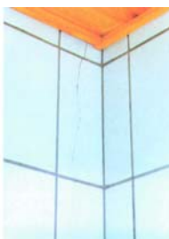
Revner i ydervæg af murværk (foto: BYG-ERFA)
