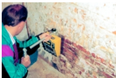
Afskalning af puds og maling (foto: BYG-ERFA)
