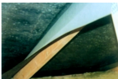
Overskydende undertagsmateriale der skal bortskæres (foto: BYG-ERFA).
