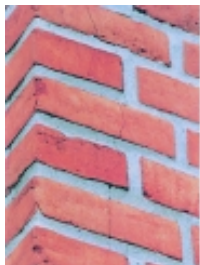
Revner i ydervæg af murværk (foto: BYG-ERFA)
