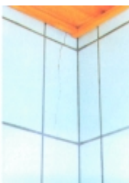
Revner i ydervæg af murværk (foto: BYG-ERFA)
