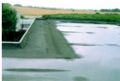
Vandsamling på fladt tag (foto: BYG-ERFA).
