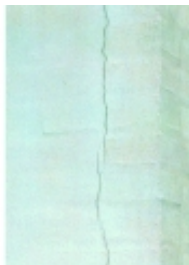
Revner i ydervæg af murværk (foto: BYG-ERFA)
