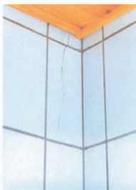
Revner i ydervæg af murværk (foto: BYG-ERFA)
