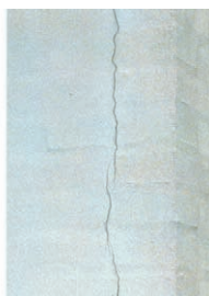
Revner i ydervæg af murværk (foto: BYG-ERFA)
