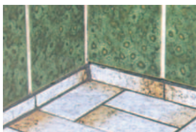
Utætte fuger gulv-væg (foto: BYG-ERFA)
