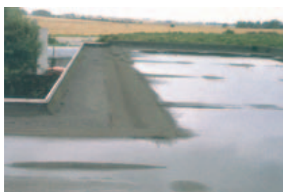
Vandsamling på fladt tag (foto: BYG-ERFA).
