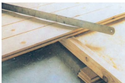
Bræddegulv med "vaskebræt"-overflade (foto: BYG-ERFA)
