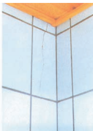
Revner i ydervæg af murværk (foto: BYG-ERFA)
