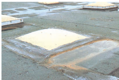
Flere gange forsøgt tætning (foto: BYG-ERFA).
