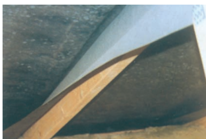
Overskydende undertagsmateriale der skal bortskæres (foto: BYG-ERFA).
