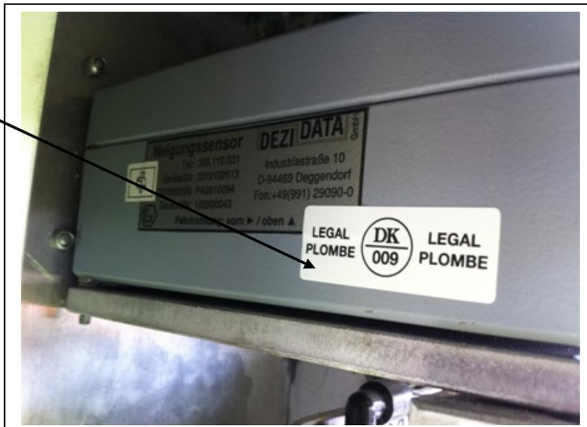
Inklinatorsensor mod åbning
